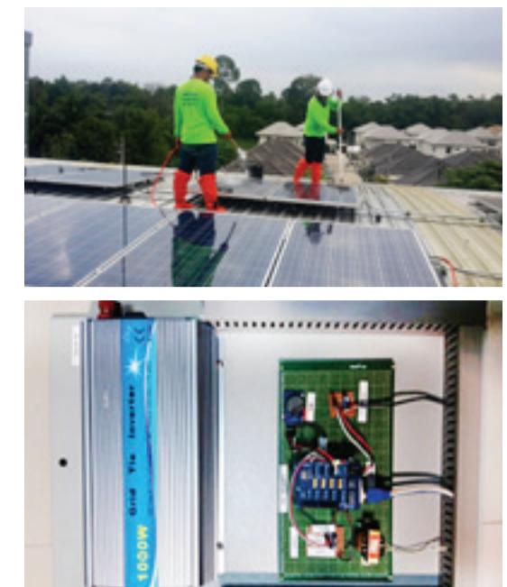
“จากการทดลองนี้พบว่า แผงโซลาร์เซลล์ที่ไม่ได้รับการทำความสะอาดจะมีประสิทธิภาพลดลง 6 เ帛รช์เซนต์ ในเวลา 2 เดือน (ทั้งนี้ขึ้นอยู่กับพื้นที่และฤดูกาล) หลังจากที่ได้ทำการล้างตามที่อุปกรณ์ต้นแบบที่ส่งสัญญาณเตือนและระบบที่ได้ออกแบบแล้วทำให้ประสิทธิภาพของแผงโซลาร์เซลล์กลับมาสูงเหมือนเดิม ซึ่งทำให้เห็นว่าการล้างไม่จำเป็นต้องทำเป็นรอบตามที่ปฏิบัติกันมาในโซลาร์ฟาร์ม ทั้งนี้ควรจะเลือกล้างเฉพาะแผงที่จำเป็นต้องล้างเท่านั้น” ผศ.ดร.สุรเชษฐ์ กล่าว
